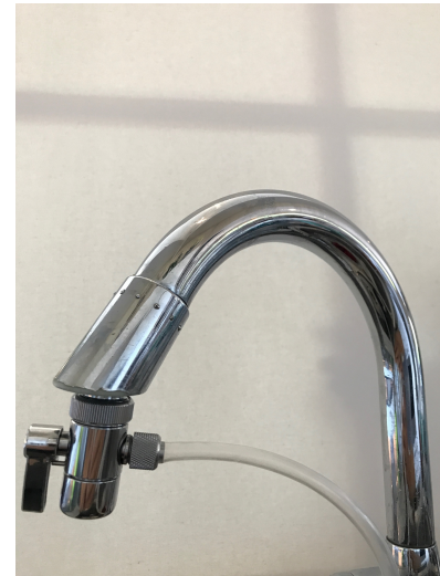
Når universal-koblingen/bryteren er skrudd på kan du koble til vannledningen
