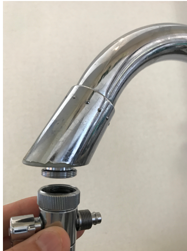
Skru deretter universal-koblingen/bryteren på adapteret
